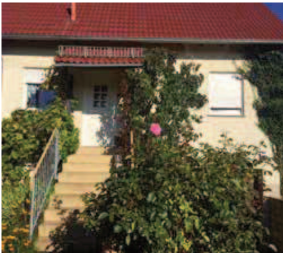
Das Haus der Eheleute Känner aus Dresden ist wieder ein Schmuckstück geworden – ohne immensen Bauaufwand.
